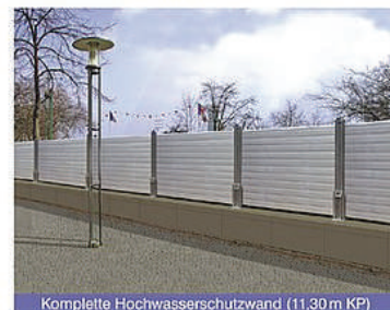
Komplette Hochwasserschutzwand (11,30 m KP)
