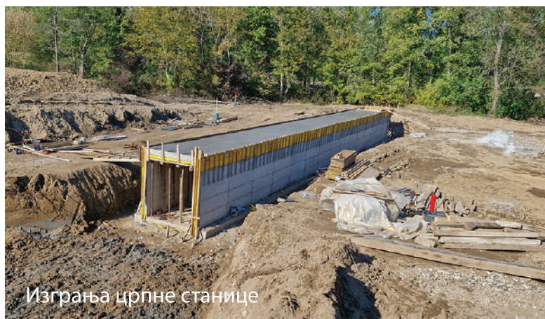
Изградња црпне станице
